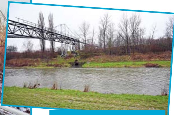
Místo, kde vznikne nová lávka.
